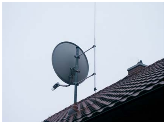
Rys. 4. Ochrona masztu i anteny przed bezpośrednim oddziaływaniem prądu piorunowego [14]
