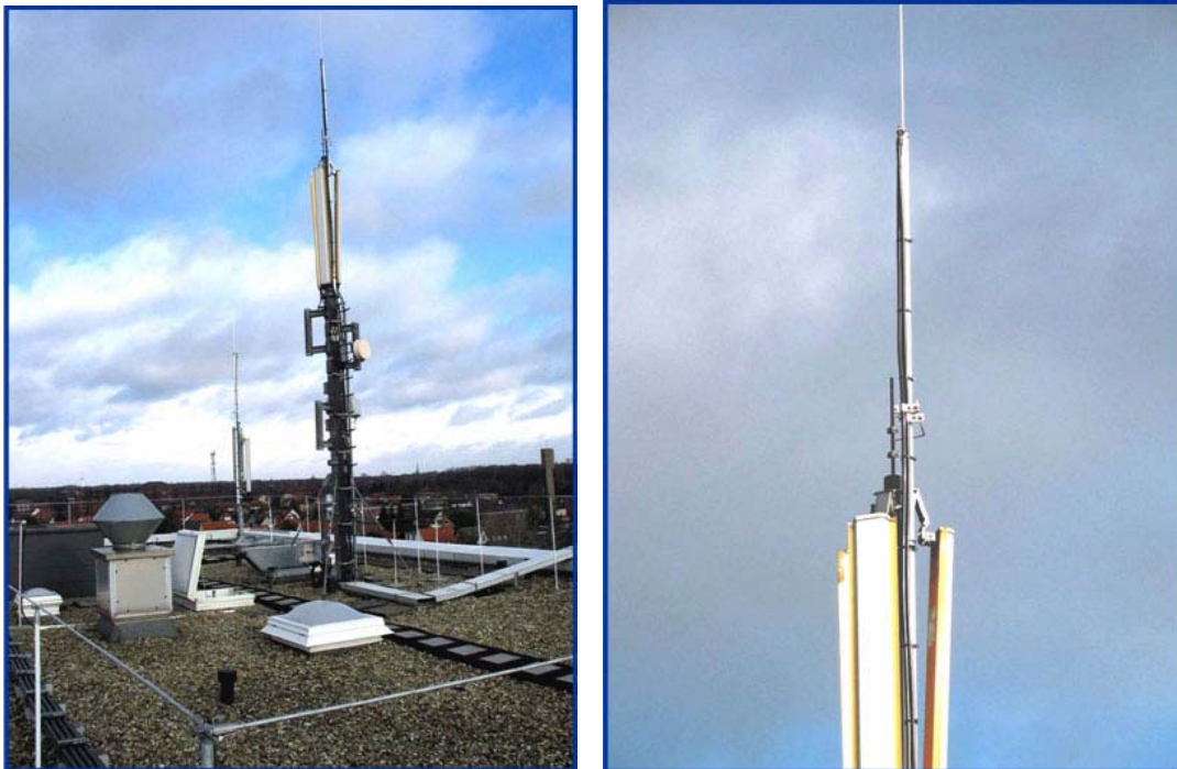
Rys. 8. Przykład wykorzystania kabla w izolacji wysokonapięciowej pokrytej materiałem półprzewodzącym do odprowadzania prądu piorunowego
