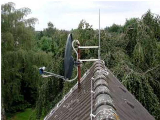
Rys. 6. Ochrona masztów antenowych i anten przed bezpośrednim oddziaływaniem prądu piorunowego [14]
