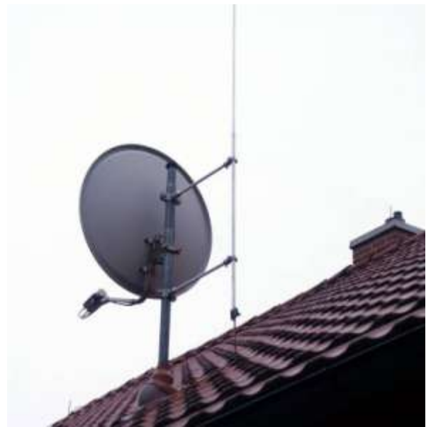
Rys. 6. Ochrona masztów antenowych i anten przed bezpośrednim oddziaływaniem prądu piorunowego [14]
